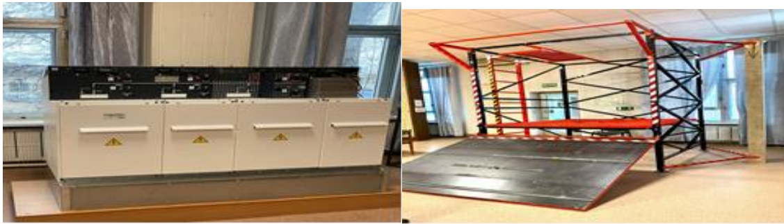
Рис.11. Демонстрационный образец RM 6 (КРУЭ 6-10кВ) производство АО «Шнайдер Электрик» Рис. 12. Учебно-тренировочный полигон для обучения практическим навыкам работ на высоте
